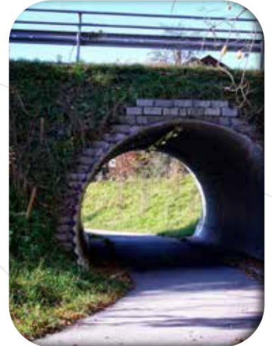
KÖPRÜ ve TÜNELLER
